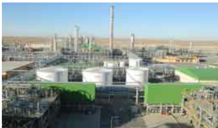
Рис. 2. Территория Устюртского газо-химического комплекса «Uz-Kor Gas Chemical» (2023 г.)
